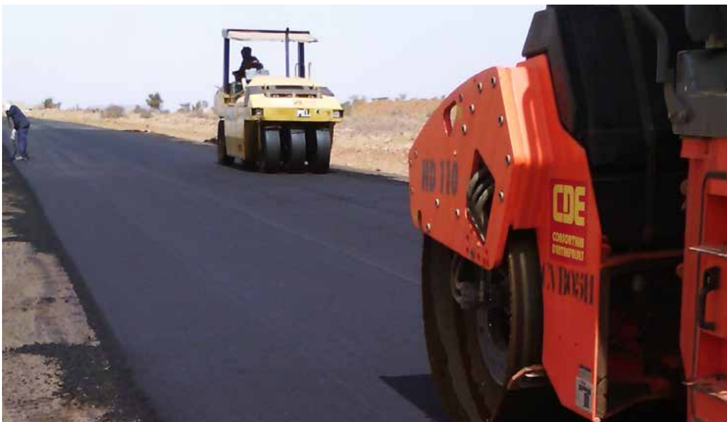
Enrobe tronçon Rastaref-Aoujeft (MAURITANIE)
